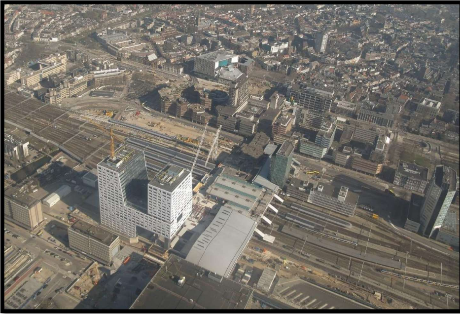
Station Utrecht CS: een brug te ver voor Best om op de spoortunnel te gaan bouwen
