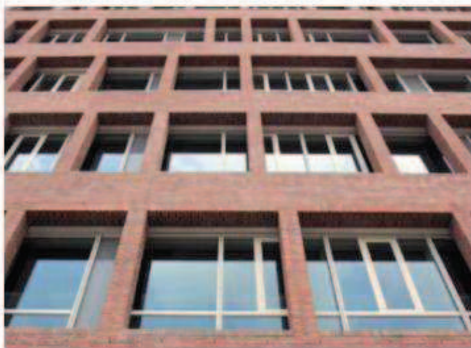
Gevelmetselwerk met diepe negge.
