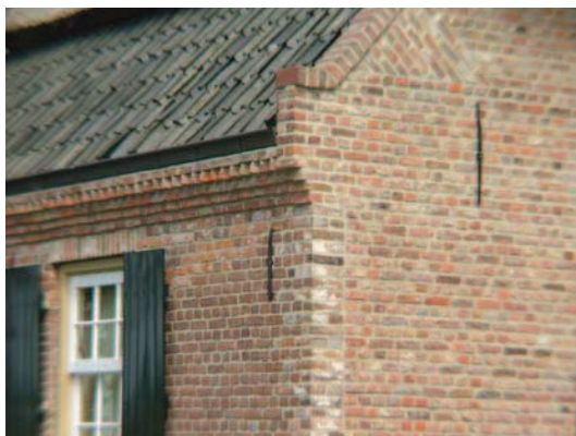
Detail metselwerkverband met verbijzonderingen
