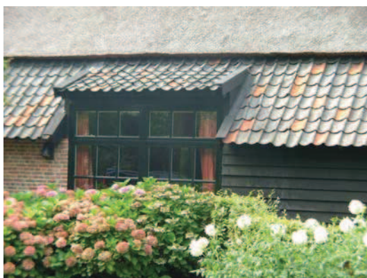
Verbijzondering in dak | Staldeuren
