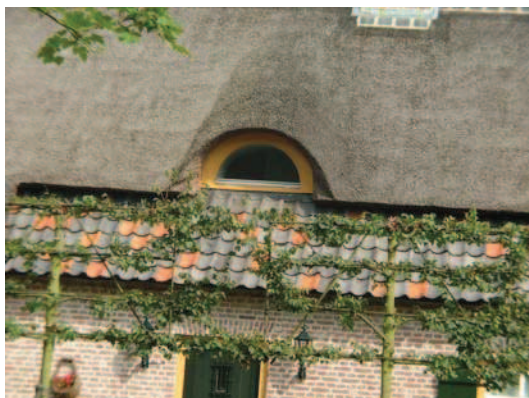
Kattenog in Rieten dak
