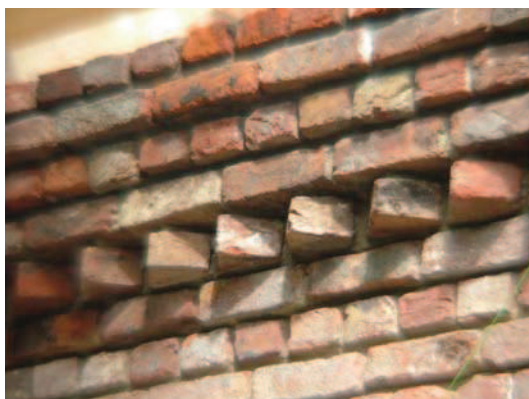
Metselwerkverbijzondering onder goot
