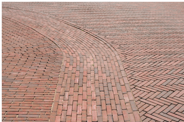
Onderscheid tussen rijbaan en trottoir wordt gemaakt door de stenen in verschillende verbanden te leggen.
