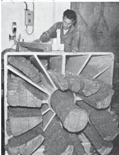
In de walsen wordt het ruwe rubber gekneed, gemengd en gewalst tot platen (bron: Bata, ca. 1959).
