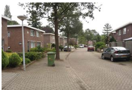
De ritmiek van de blokjes met open intervallen en de continuïteit van de geprononceerde daklijsten zorgen voor een plastisch geëeld straatgevelbeeld.
