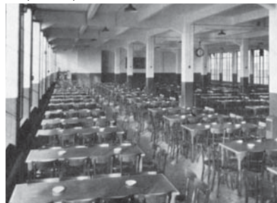
De kantine in het fabrieksgebouw doet tevens dienst als restaurant (bron: Bata, ca. 1959).
