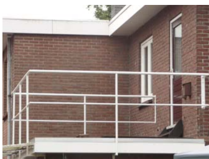
balkonhek van stalen buizen
