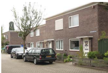
Herhaling van gevelcomposities, identieke entrees en consequent materiaalgebruik zorgen voor samenhang in het straatgevelbeeld.
