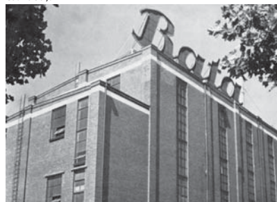
Het ketelhuis annex watercentrale levert verwarming en schoon water (bron: Bata, ca. 1959)
