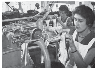
In de kousenfabriek worden kousen en sokken gebreid, geketteld en gevormd (bron: Bata, ca. 1959).
