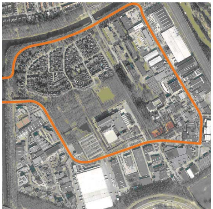
Het onderzoek heeft primair betrekking op de resterende authentieke delen van de Batakolonie, en secundair op het oranje omlijnde gebied.
