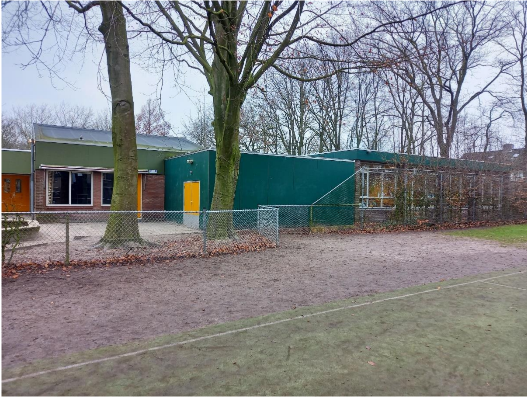
Figuur 6. Impressie plangebied, met op foto het te slopen gedeelte en de nieuwbouwlocatie.
