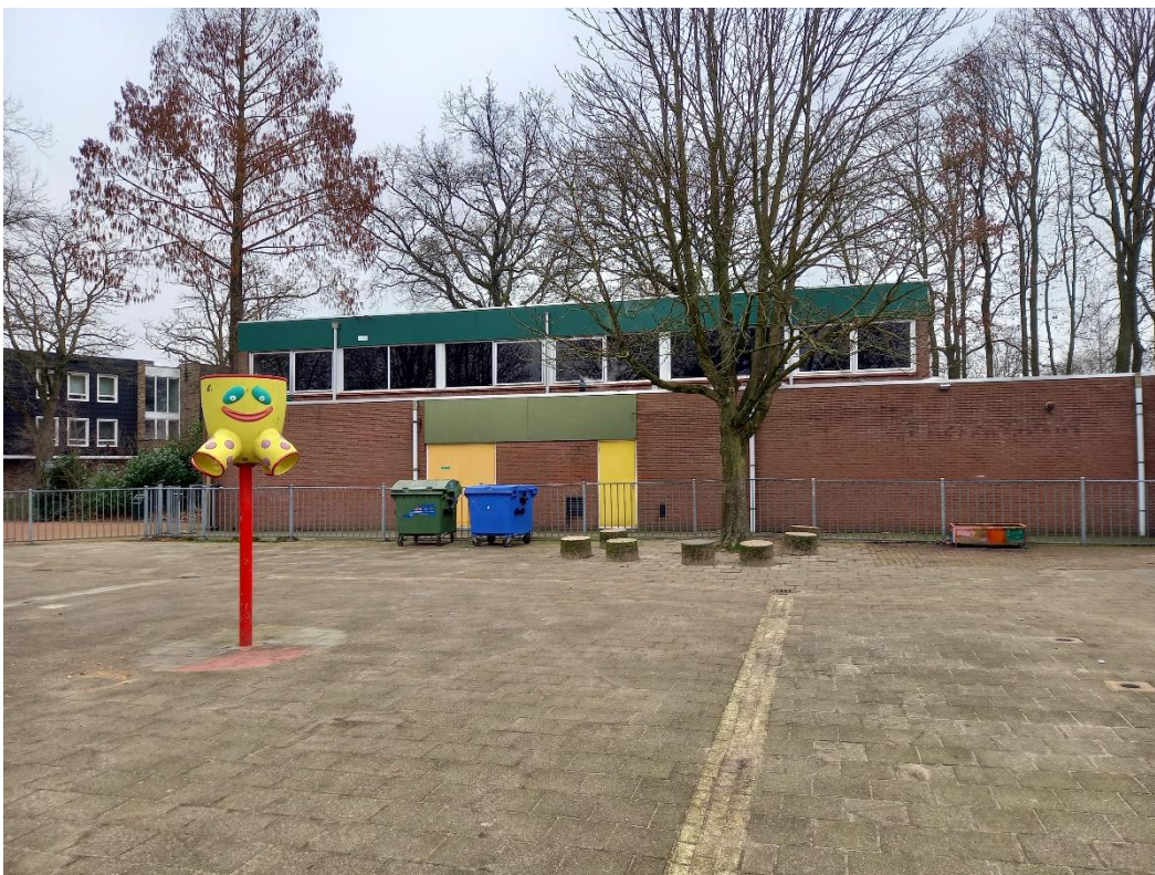
Figuur 5. Impressie plangebied, met op foto de te slopen gymzaal.
