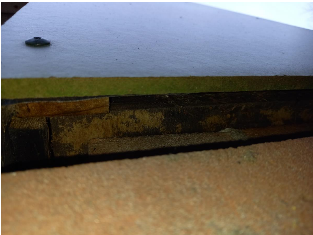
Figuur 9. Ruimte tussen buitenmuur en dakafwerking biedt potentieel geschikte verblijfplaatsen aan vleermuizen achter het houtwerk en in de dak- en spouwruimtes van het gebouw.
