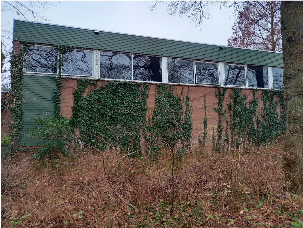
Figuur 4. Impressie plangebied, met op foto de te slopen gymzaal.
