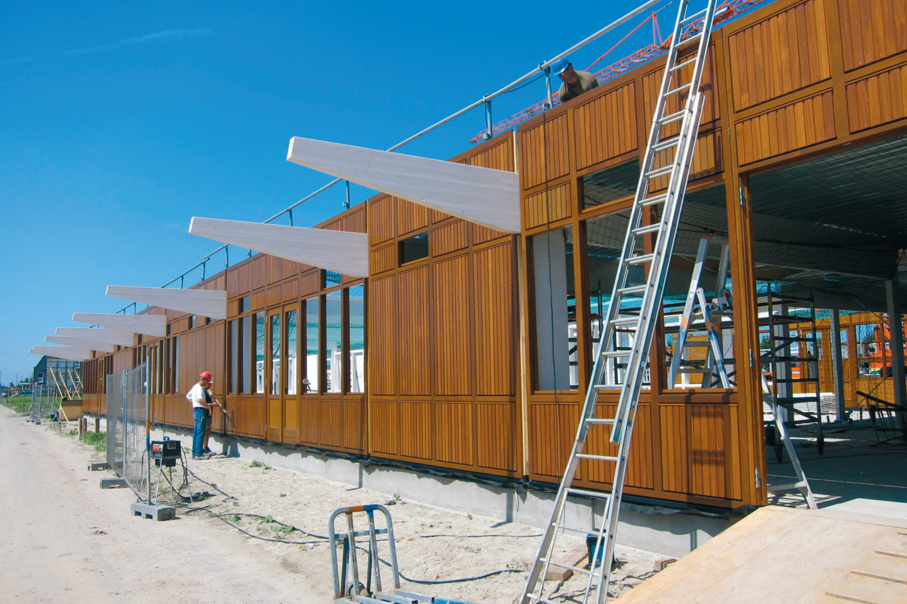
Prefab gevelpanelen met kozijnen plaatsen | bouwtijd van 1 jaar naar 6 maanden (let op begroting aannemer!)
