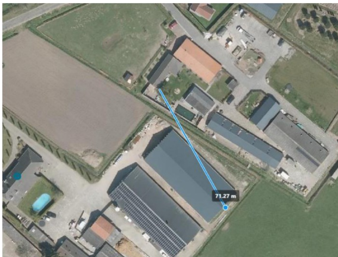
Gedooog- / Overgangssituatie juli 2022
