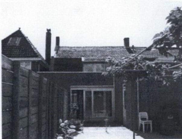
Achtergevel pand Nieuwstraat 25
