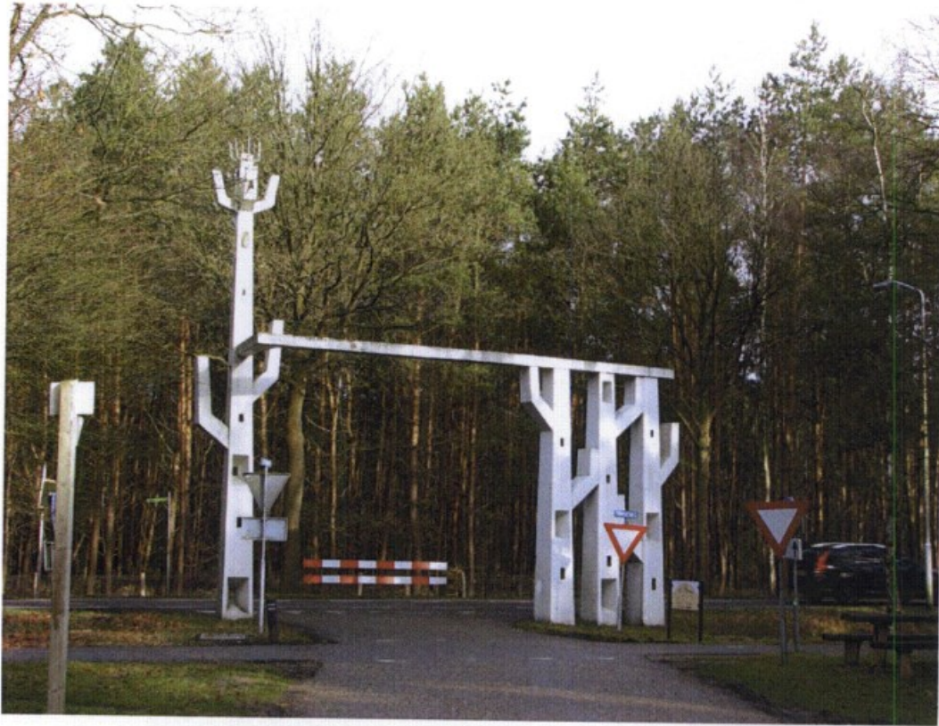
Toegangspoort aan de Sonseweg van de Joe Mannweg
